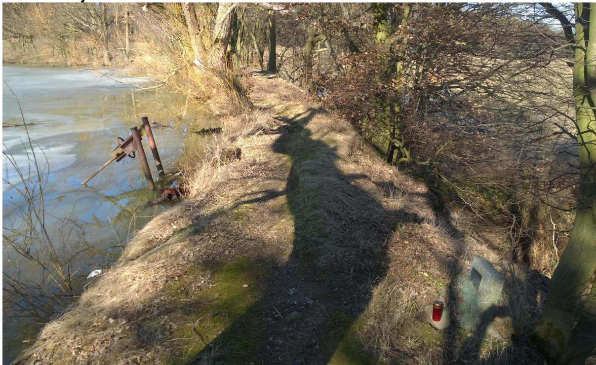
VN4 - stávající vyústění zatrubněného odtoku z vypoštěcího zařízení
